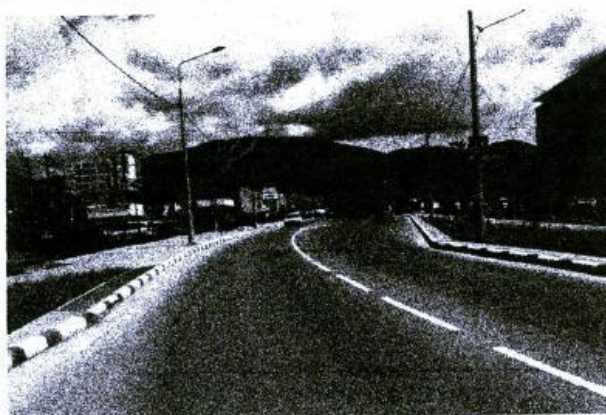
Реконструкция дорожного покрытия
